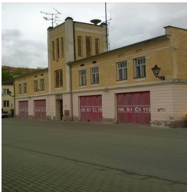
Obrázek 8 Budova bývalé hasičské zbrojnice (vlastní zpracování, 28. 4. 2016)
