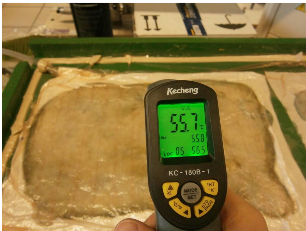
Obr. 24. Kontrolní měření teploty při vytvrzování
