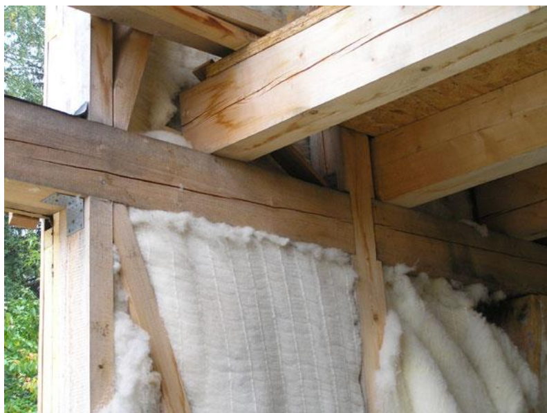
Obr. 12. Izolace roštových stěn [19]
