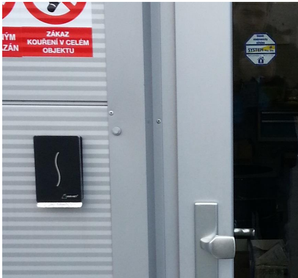
Obr. 8 Přístupový systém [Vlastní]
