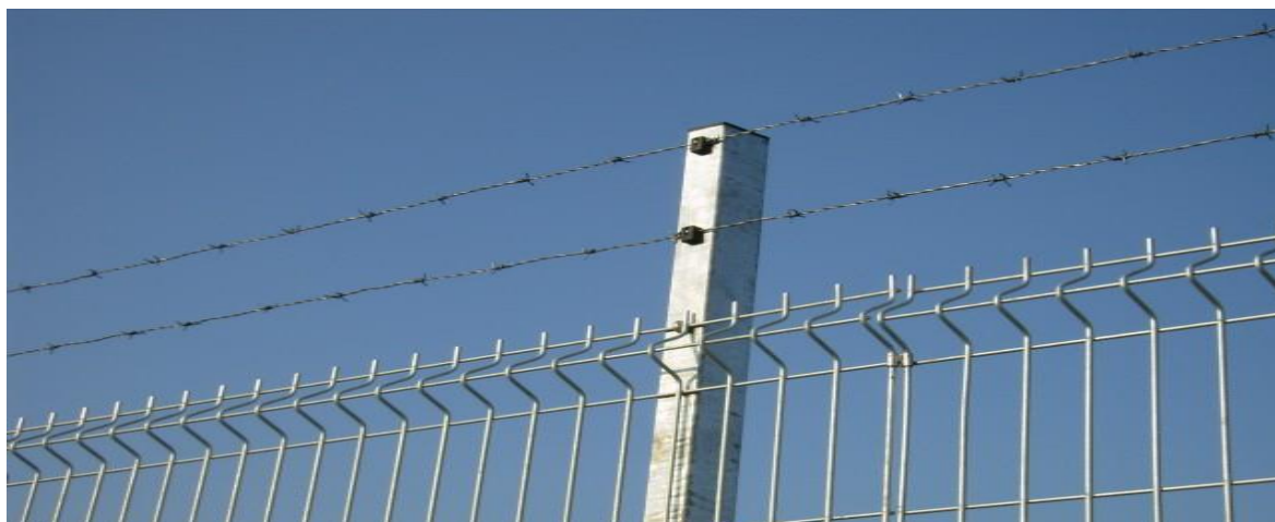
Obrázek č. 17- Vrcholová zábrana v podobě ostnatého drátu [40]
