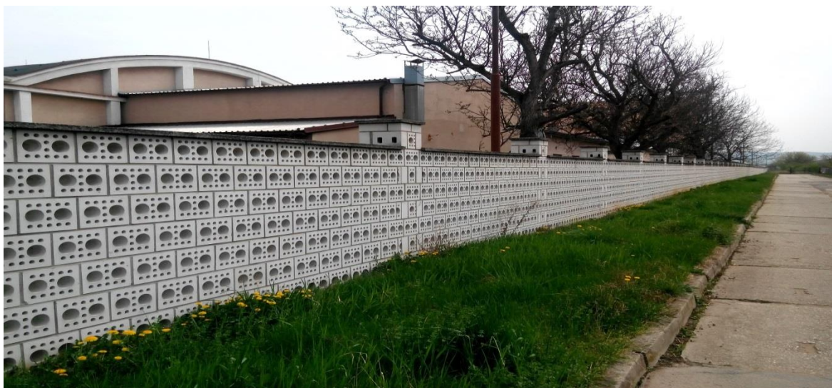
Obrázek č. 15- Obvodová ochrana areálu, pohled ze západu [Zdroj: autor]
