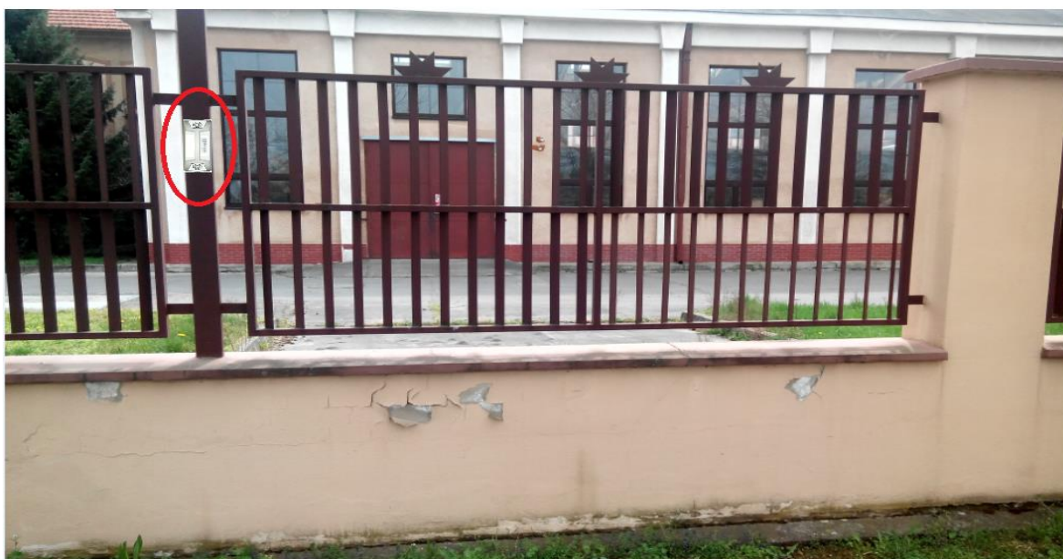
Obrázek č. 21- Princip instalace RFID na plot [Zdroj: autor]
