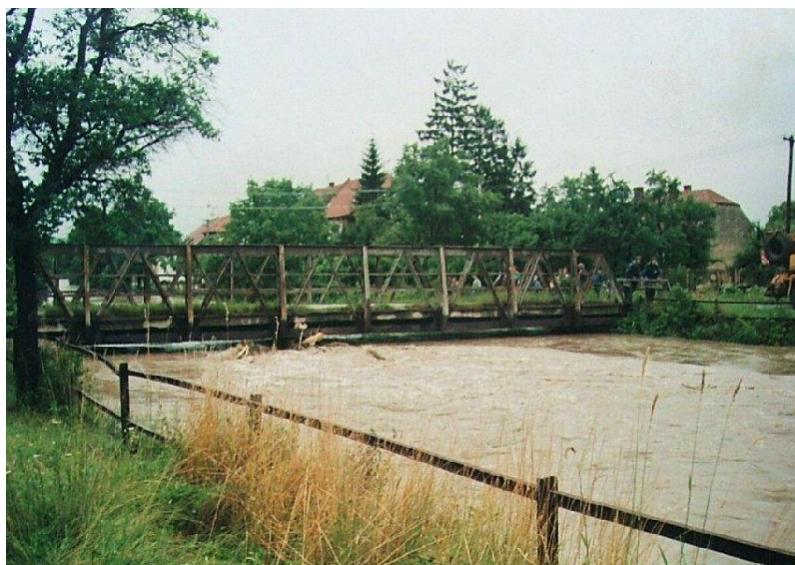
Obr. 1 – Pohled na most přes řeku Olšavu z ulice Na Řádku na ulici Olšavní
