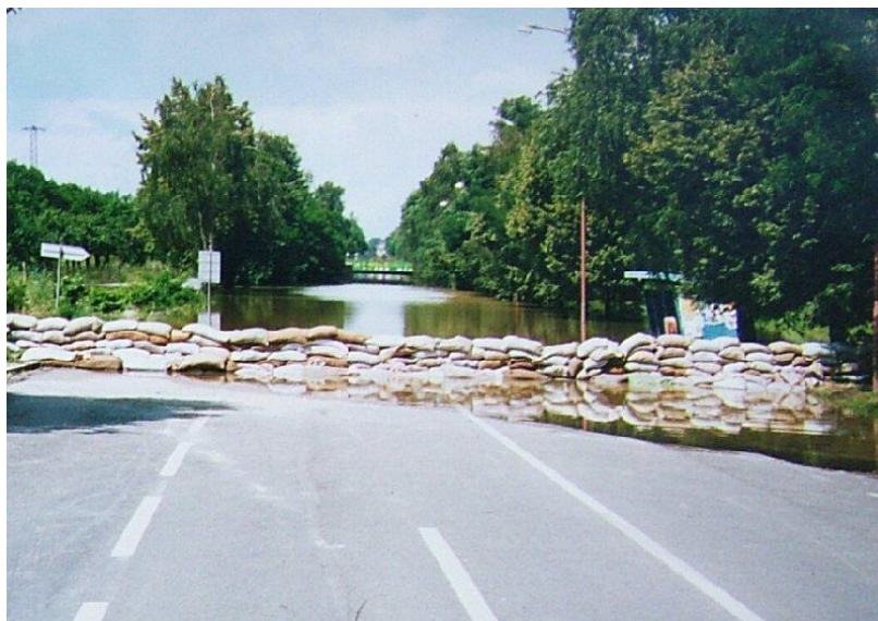
Obr. 7 – Zatopená silnice pod železničními mosty z Kunovic do Uherského Hradiště
