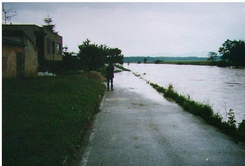
Obr. 5 – Zatopení nejnižšího místa a vjezd do rodinného domu v ulici Potočná
