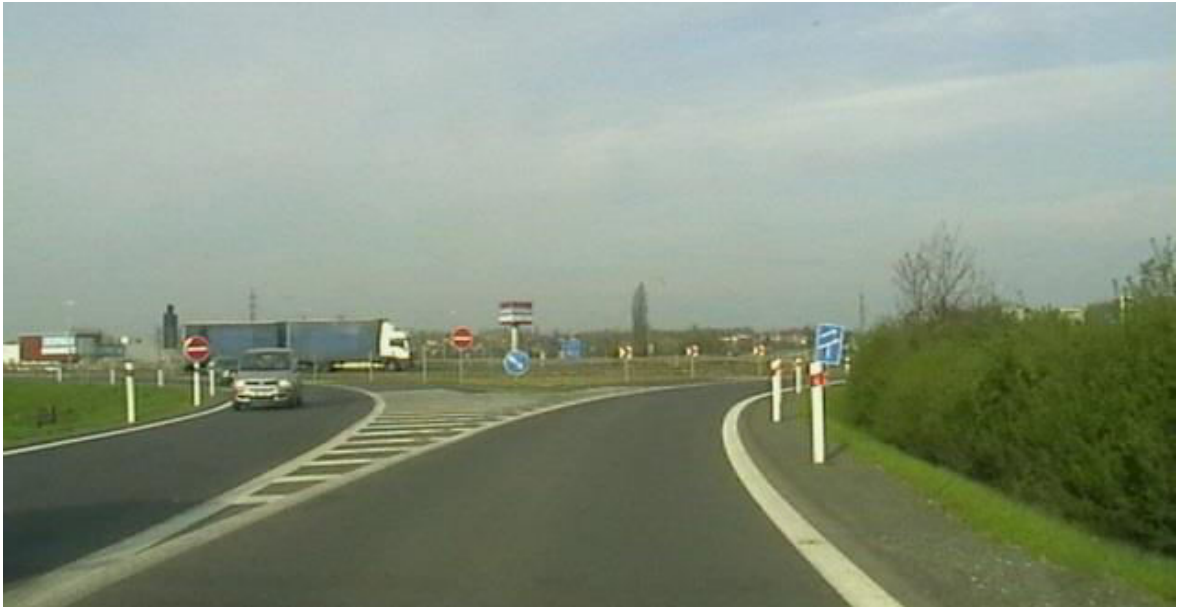
Obr. 19 Nájezd a sjezd dálnice D2 ve směru Brno – Břeclav [53]
