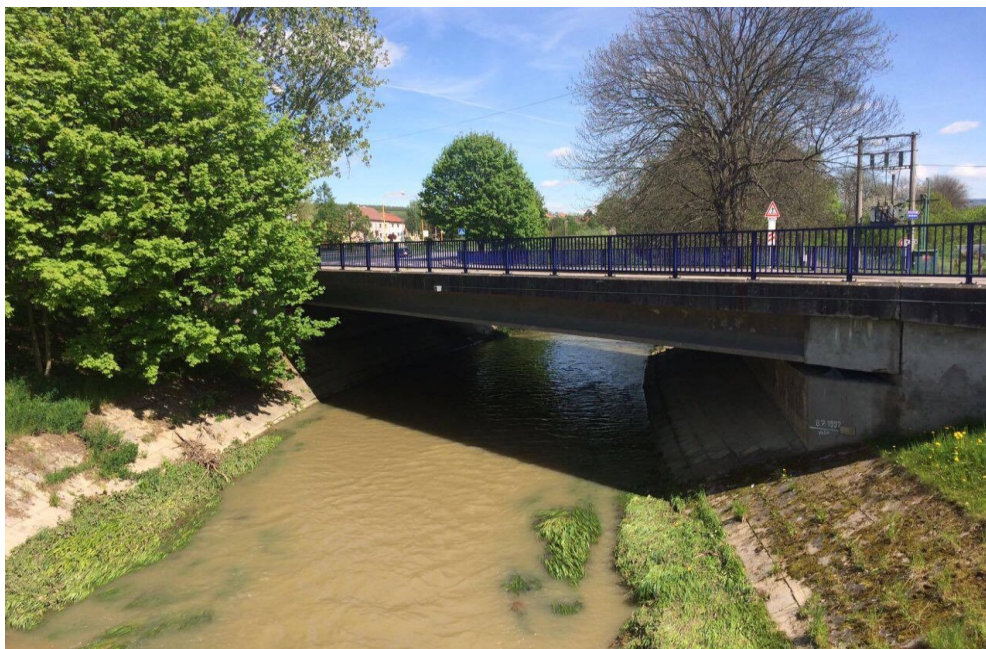
Obr. 5. Umístění hlásného profilu kategorie C na mostě č. 495-023 [Zdroj: vlastní]
