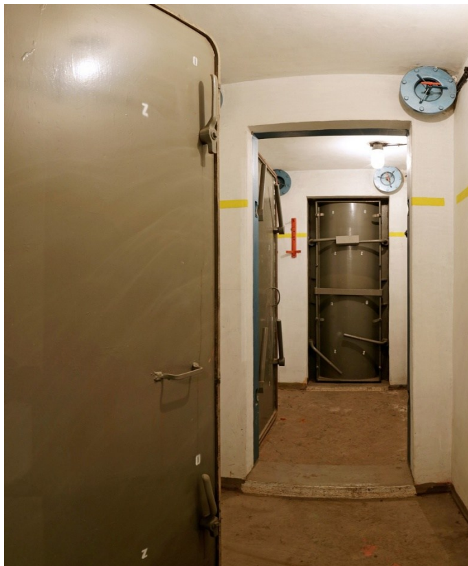
Obrázek 28 – Domovní úkryt (tlakově plynotěsná vrata) [36]
