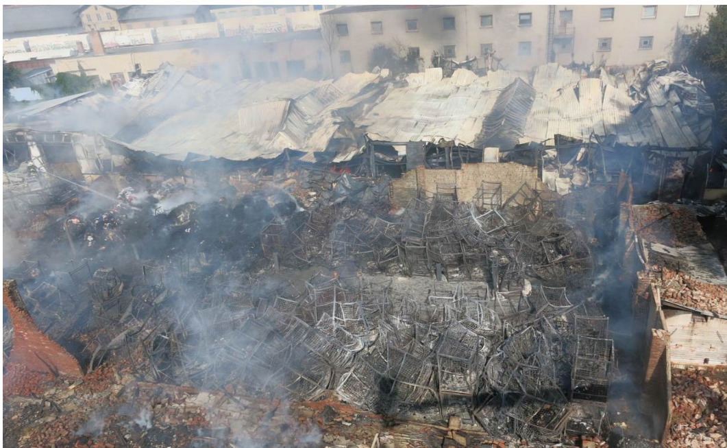
Obrázek 9: Pohled na následky požáru. [23]
