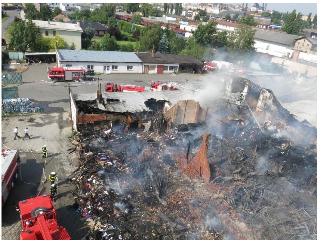
Obrázek 15: Pohled na halu 3 a administrativní část. [23]
