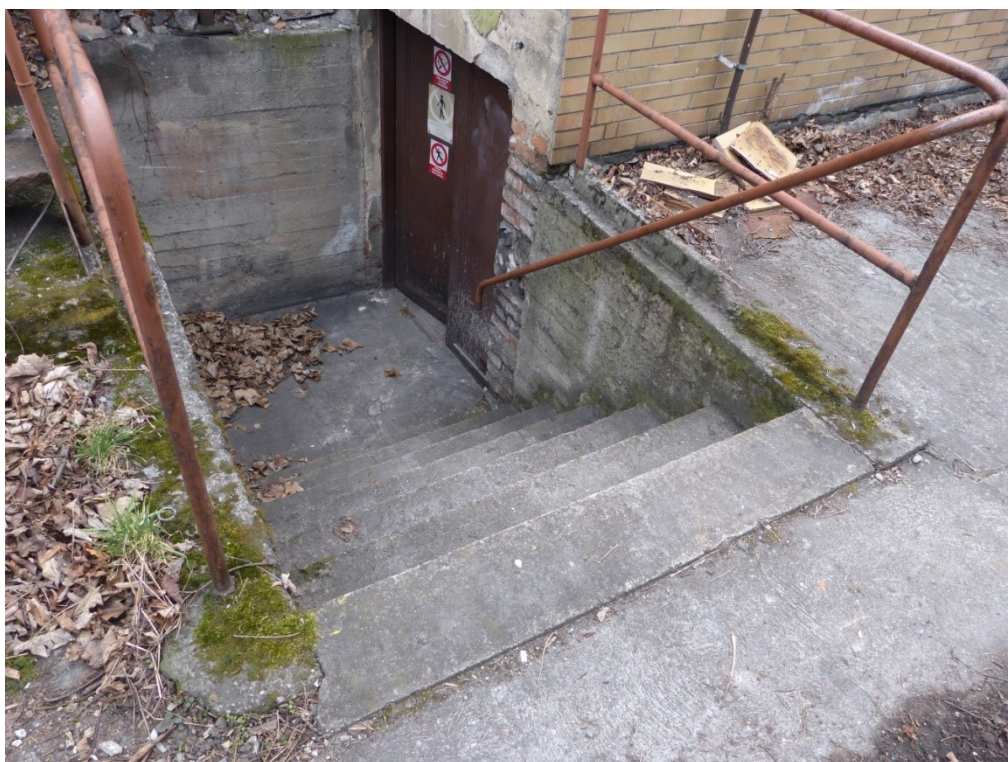
Obr. 19. Schodiště do technické části, Zdroj: [vlastní]
