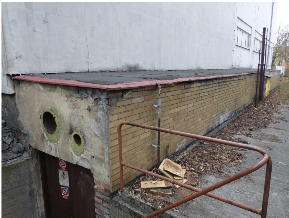
Obr. 21. Rampa – současný stav, Zdroj: [vlastní]
