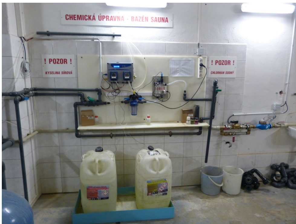
Obr. 22. Chemická úpravna – současný stav, Zdroj: [vlastní]
