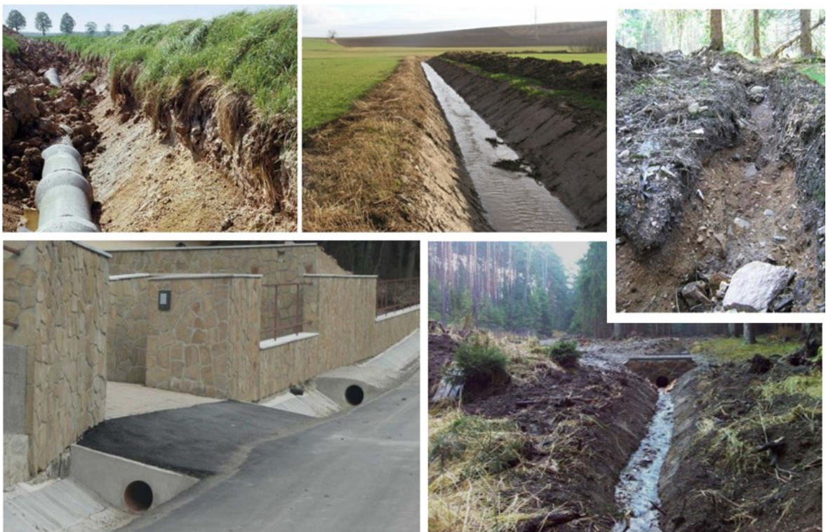
Obrázek 4. Nevhodné odvodnění zemědělské půdy, lesů a sídel. [11]
