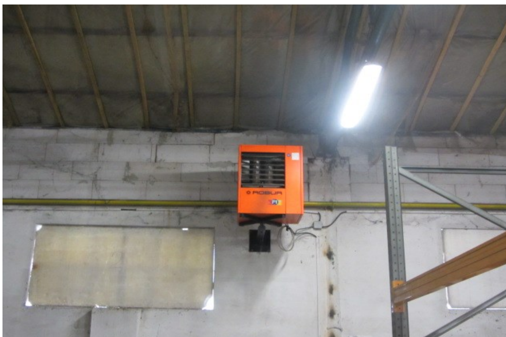
Obr. 14. Průmyslová teplovzdušná plynová jednotka ROBUR F1 [22]
