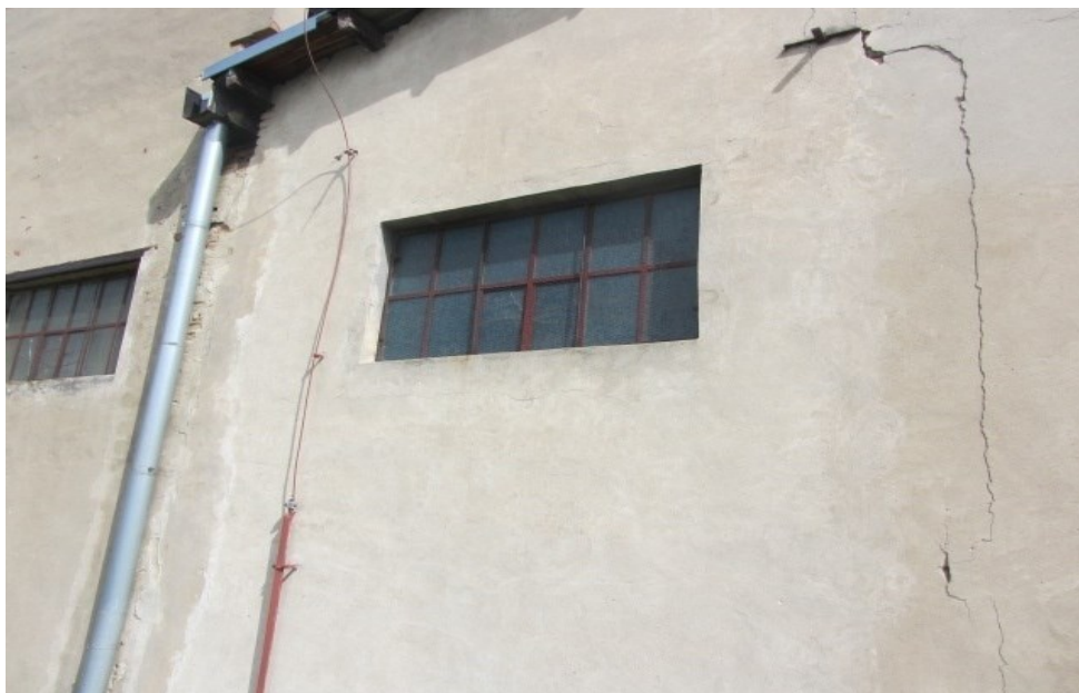
Obr. 17. Okna do skladu [22]
