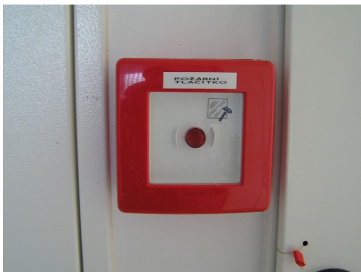
Obr. 13 Bezpečnostní tlačítko (napojené do centrály), zdroj: [vlastní]
