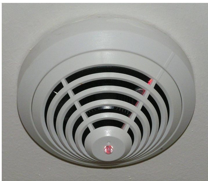
Obr. 14 Opticko – kouřový hlásič (napojený do centrály), zdroj: [vlastní]
