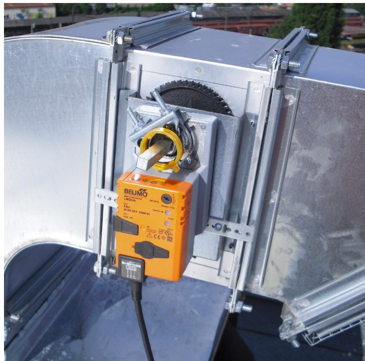
Obr. 12 Servopohon klapky, zdroj: [vlastní]
