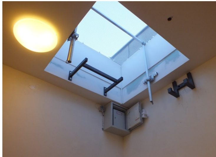
Obr. 11 Ovládaný světlik na CHÚC, zdroj: [vlastní]
