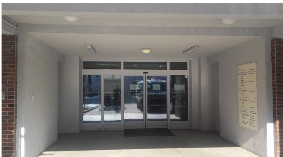
Obr. 2: Hlavní vchod do budovy interny.
