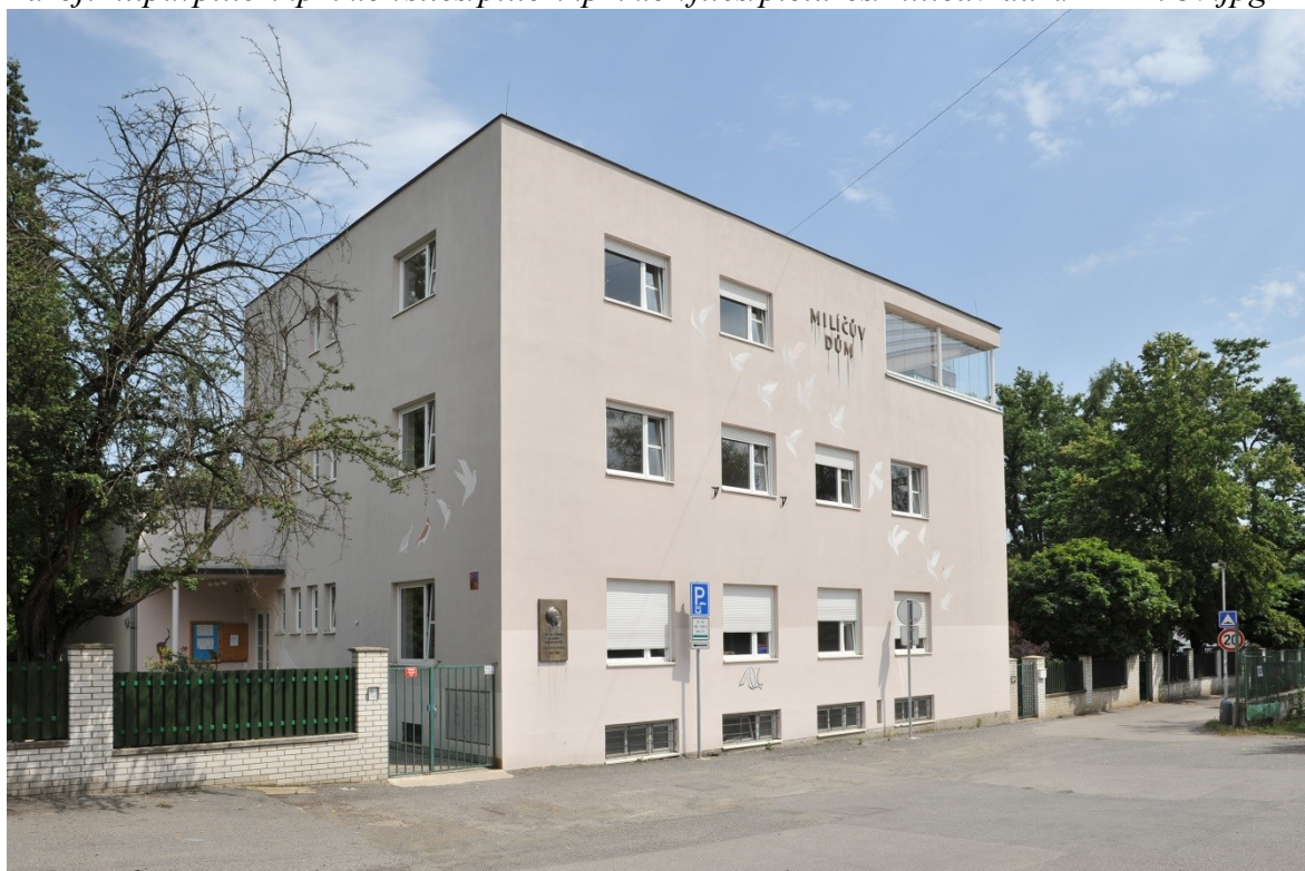
Milíčův dům, současný stav.
