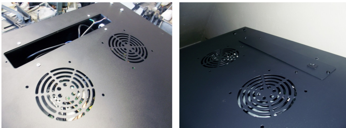
Obr. 102: Revízne okno a kryt elektroinštalácie
