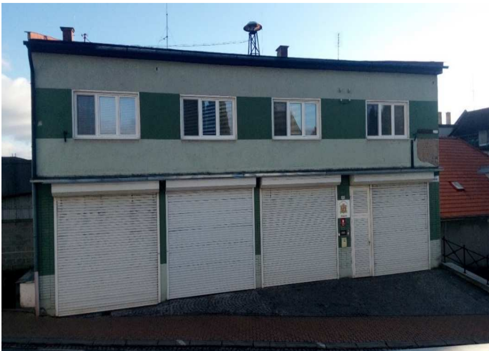
Obrázek 7 – Zbrojnice Konice [Zdroj: vlastní]
