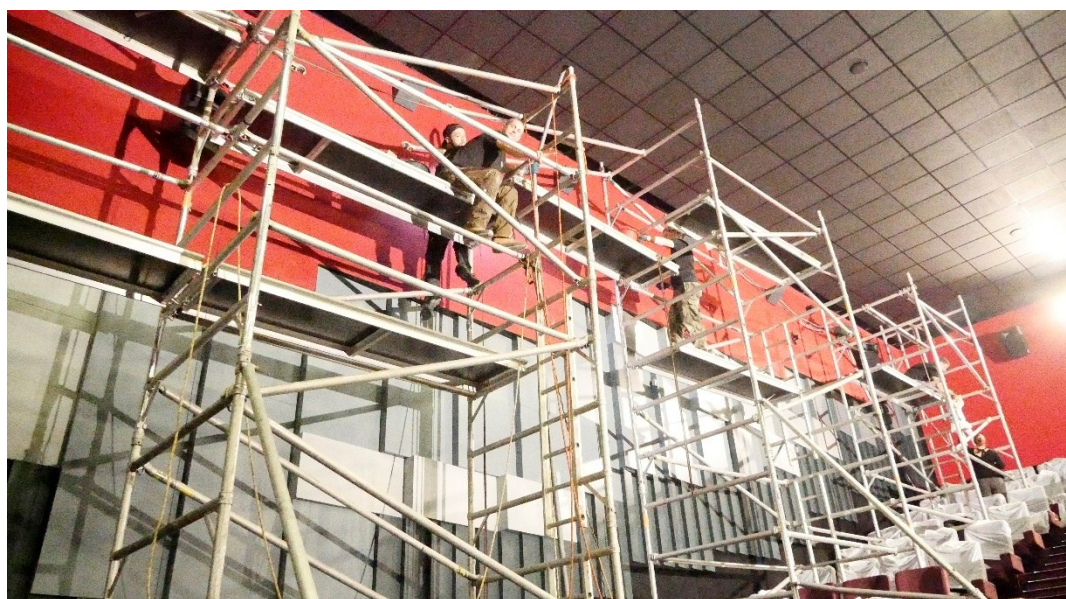
Obrázek 30 – Instalace surroundových reproduktorů
