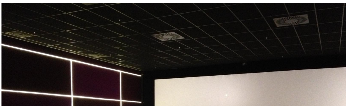
Obrázek 15 – Závěsný strop
