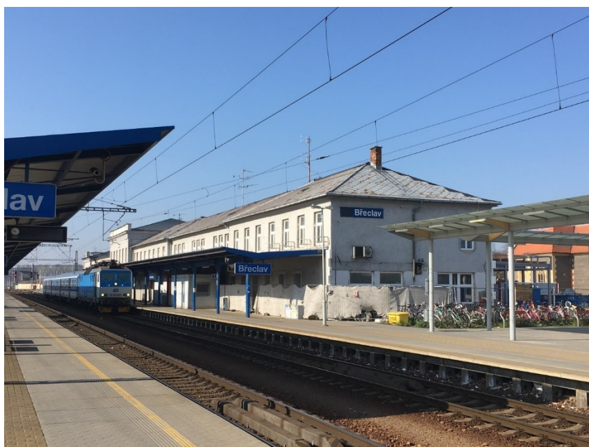
Obrázek 6 – Pohled na budovu železniční stanice Břeclav z 2. nástupiště [Zdroj: vlastní]
