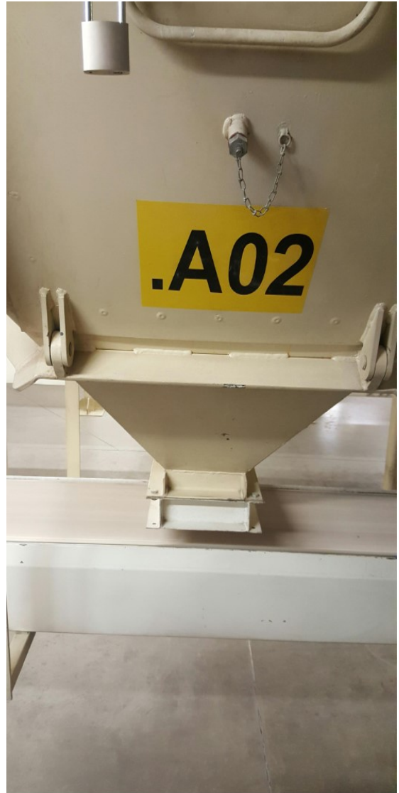
Obrázek 3- Pohled na silo ze spodu, dopravníkový pás u výsypu sila
