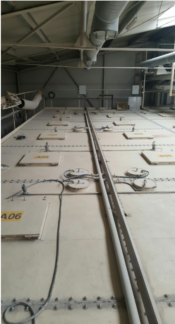
Obrázek 2 - Pohled na silo z vrchu
