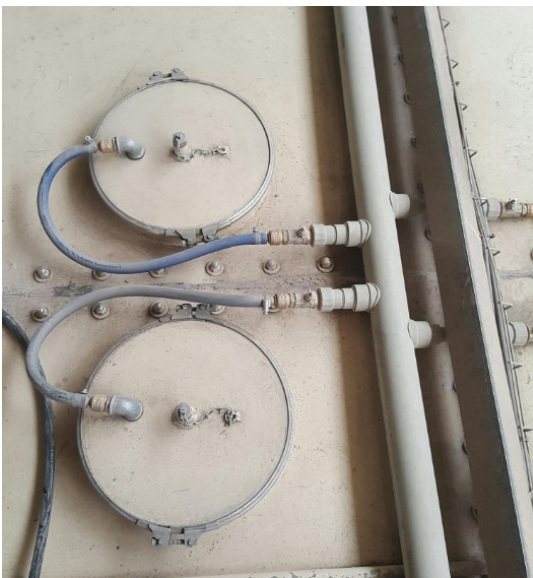
Obrázek 6 - Vrchní část sil, vývod dusíku k silu
