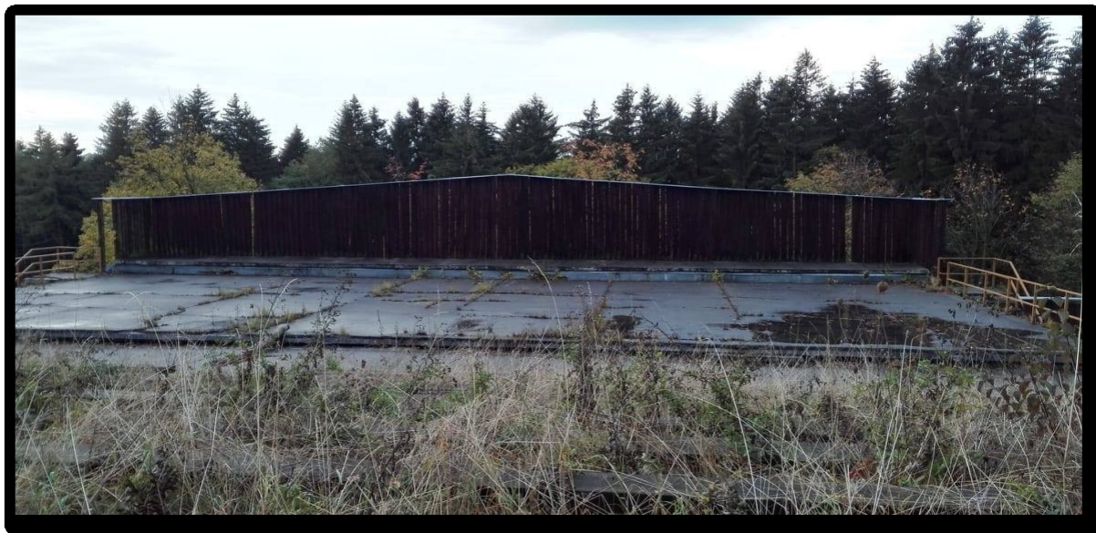
Obrázek 1 Čelní pohled na amfiteátr na Ploštině
