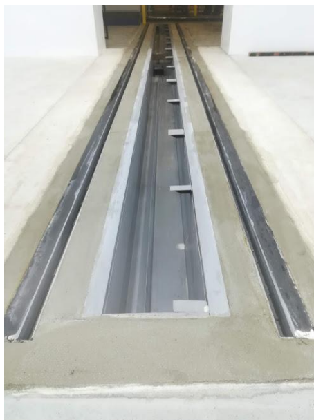
Obr. 37. Drážka po usazení a vylití kolejiště
