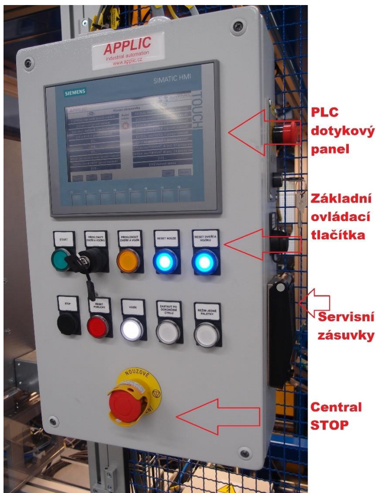
Obr. 28. Popis ovládacího panelu
