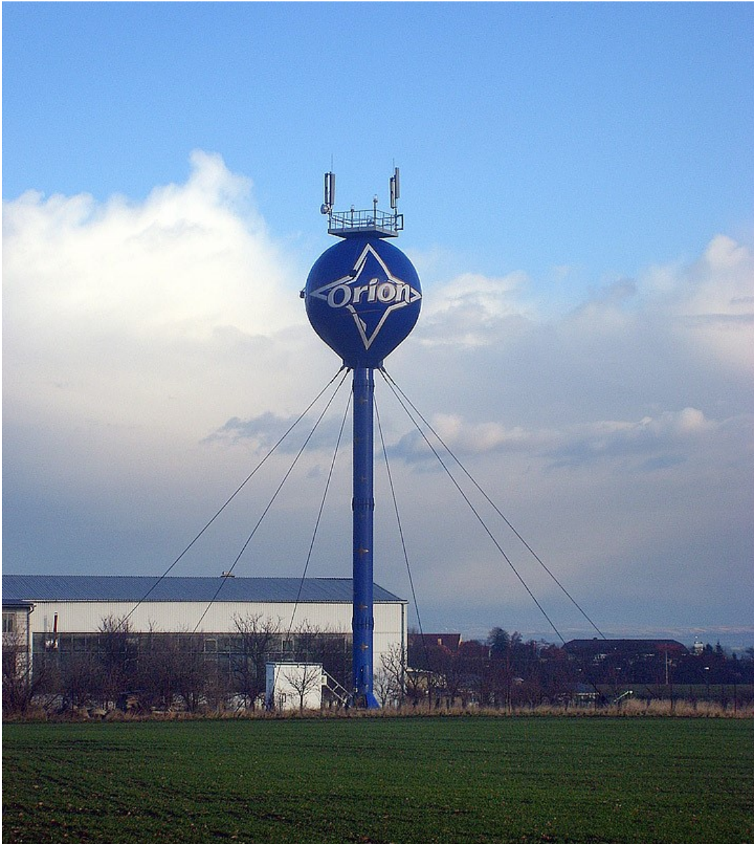
Obrázek č. 8 Orion vodárenská věž (Zdroj: Riva servis,2019)
