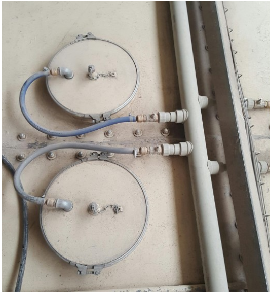
Obrázek 8 - Vrchní část sila, vývod dusíku k silu
