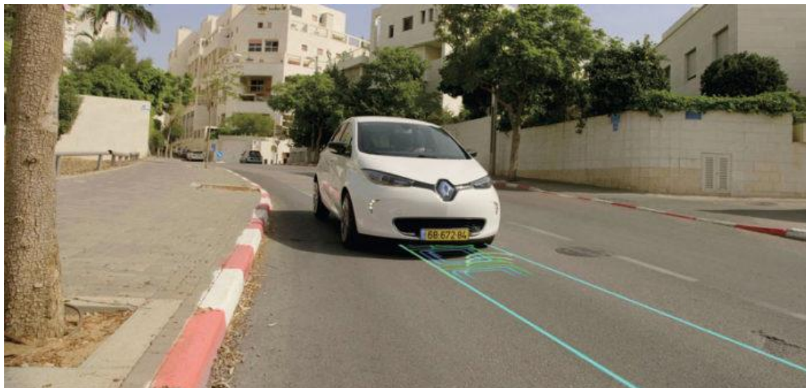
Obr. 39. Elektrifikovaná cesta od ElectReon
