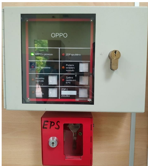
Obrázek 6 - Obslužný panel PO [Vlastní]
