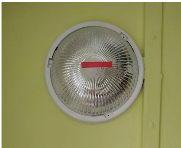
Obrázek 8 – Nouzové osvětlení [Vlastní]
