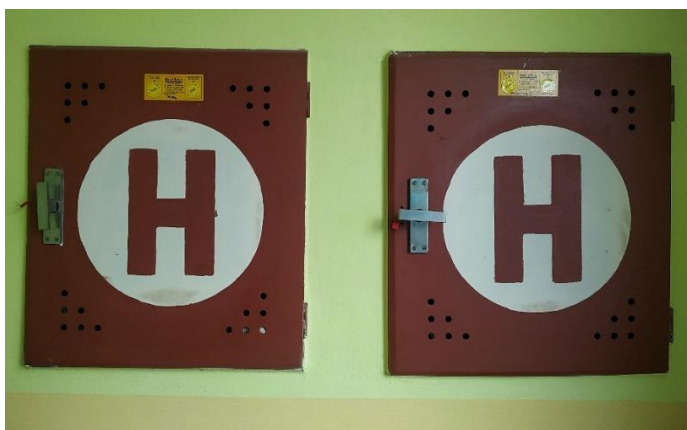
Obrázek 9 – Vnitřní nástěnné hydranty [Vlastní]
