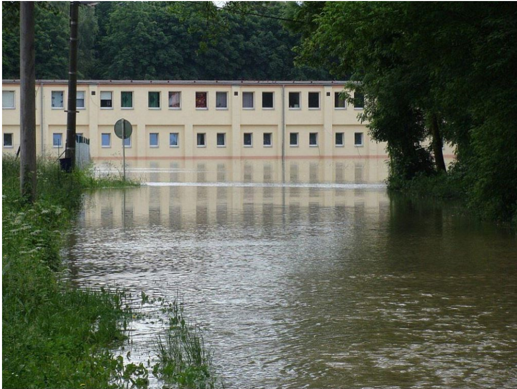
Obrázek 31: Pohled na zázemí Fotbalového stadionu v Kojetíně při povodních v roce 2010.
