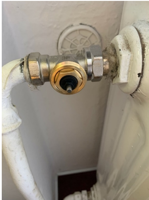
Obr. 19. Demontovaná regulační hlavice
