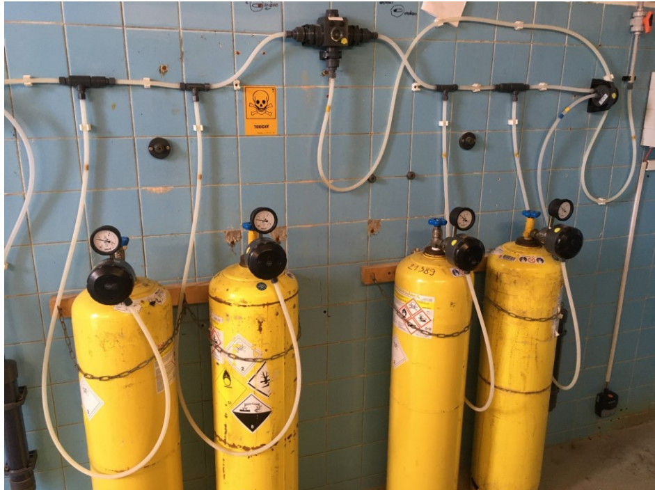
Obrázek 15 – Připojené tlakové láhve (vlastní)
