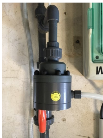
Obrázek 19 – Injektor chlóru (vlastní)
