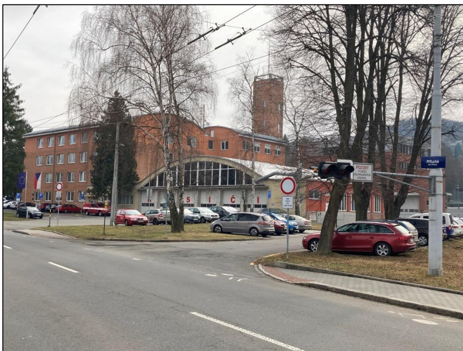
Obrázek 4 Požární stanice Zlín (Vlastní, 2022).
