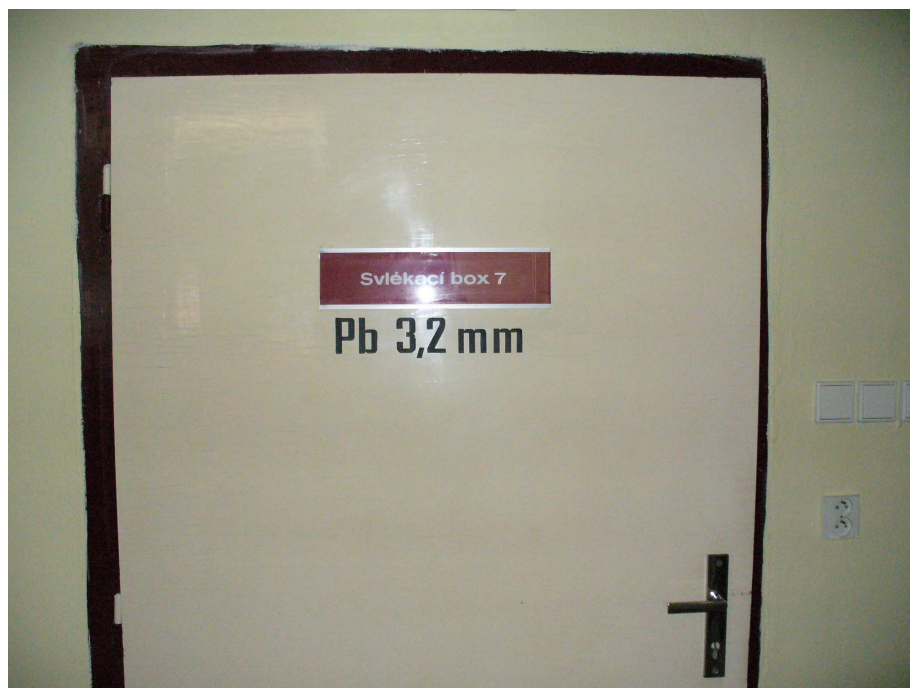
Obr. 17. Ochranné dveře s Pb vložkou. (foto: Miloš Řehák, duben 07, 2007)
