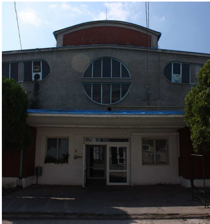
Obr. 5. Budova spoločnosti Techklima, s. r. o.
