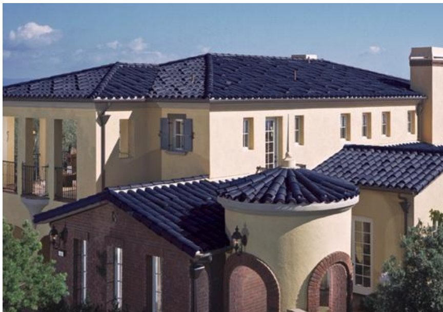
Obrázek 16 - Aplikace fotovoltaického systému na střešní krytinu
